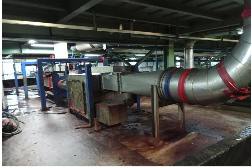
Hình 3. 16. Hình ảnh hệ thống xử lý hơi hoá chất tại xưởng vải màn
