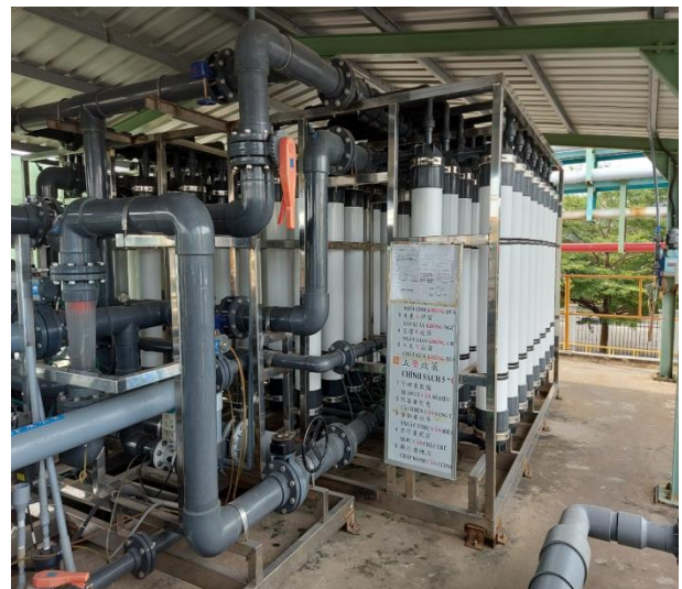
Hình 3. 13. Hình ảnh về hệ thống tái sử dụng nước thải xưởng dệt
