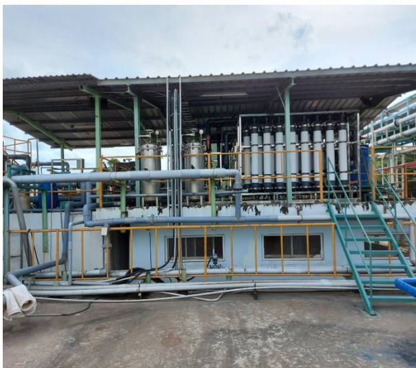
Hình 3. 13. Hình ảnh về hệ thống tái sử dụng nước thải xưởng dệt
