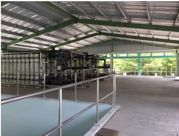
Hình 3. 15. Hình ảnh về hệ thống tái sử dụng nước thải xưởng nhuộm
