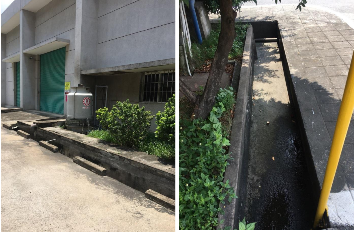
Hình 3. 2. Ống thu gom nước mưa trên mái và hồ ga dưới mặt đất
